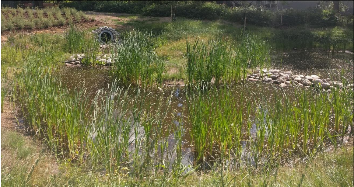
Kuva 7. Esimerkki kosteikosta ja pohjapadoista. Kuva Espoon Niittykummusta
